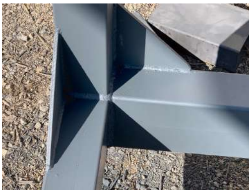
Fabricación de estructuras industrializadas transportables
