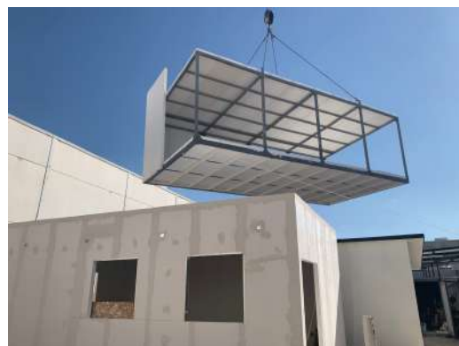
Fabricación Módulos Pre-Industrializados
