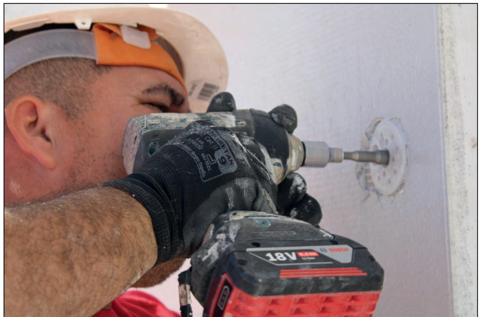
Detalle de atornillado de paneles
