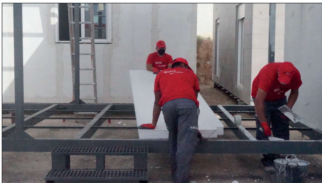
Detalle de colocación de quîckmôrtar y quîckfiber para la colocación de paneles en forjado inferior
