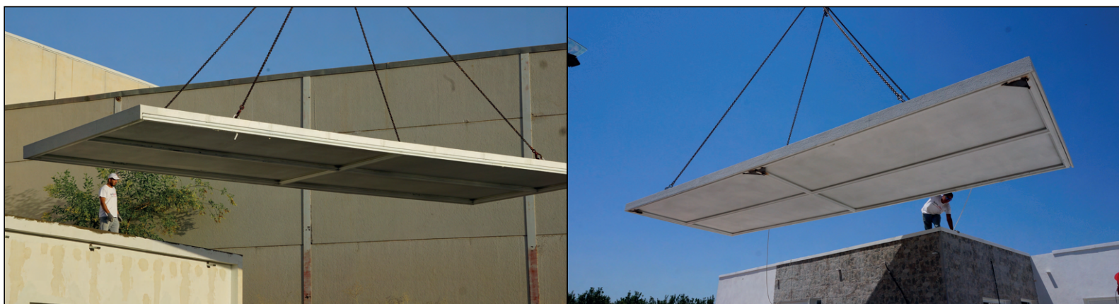
Detalle enganche pérgolas con estructura interna
