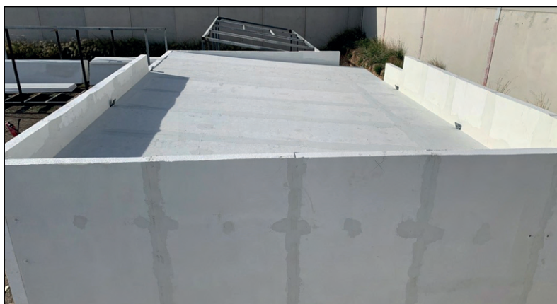
Detalle tratamiento de juntas cubierta
