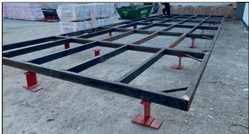
Bastidor superior metálico. Vigas transversales sobre futuros pilares.
