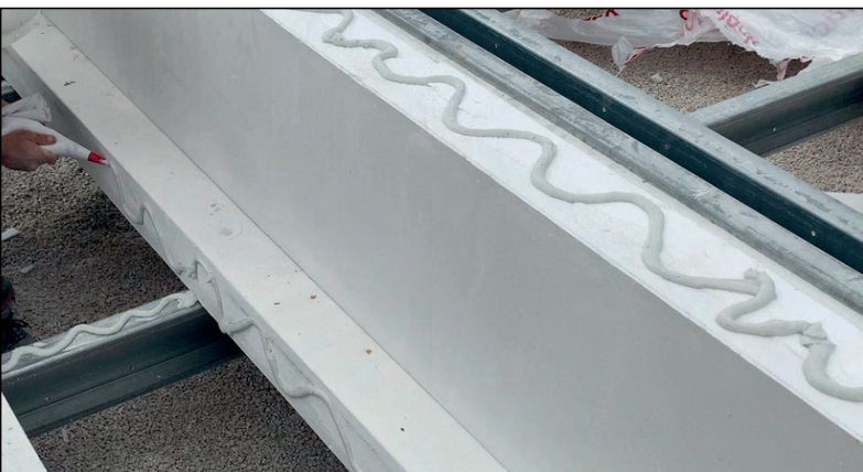
Detalle de mortero intersticial entre paneles
