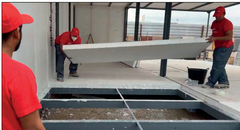
Detalle de colocación de paneles
