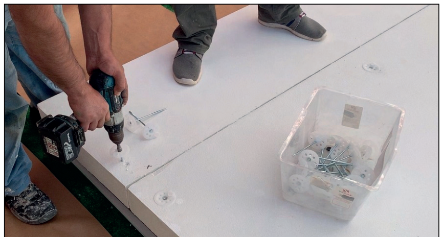
Detalle atornillado paneles
