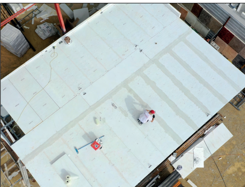
Detalle tratamiento de juntas en cubierta y detalle de pendiente
