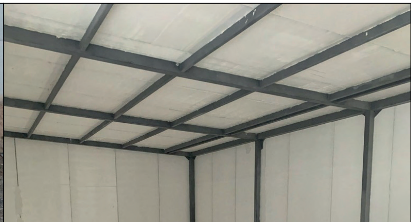
Bastidor superior por el interior del módulo
