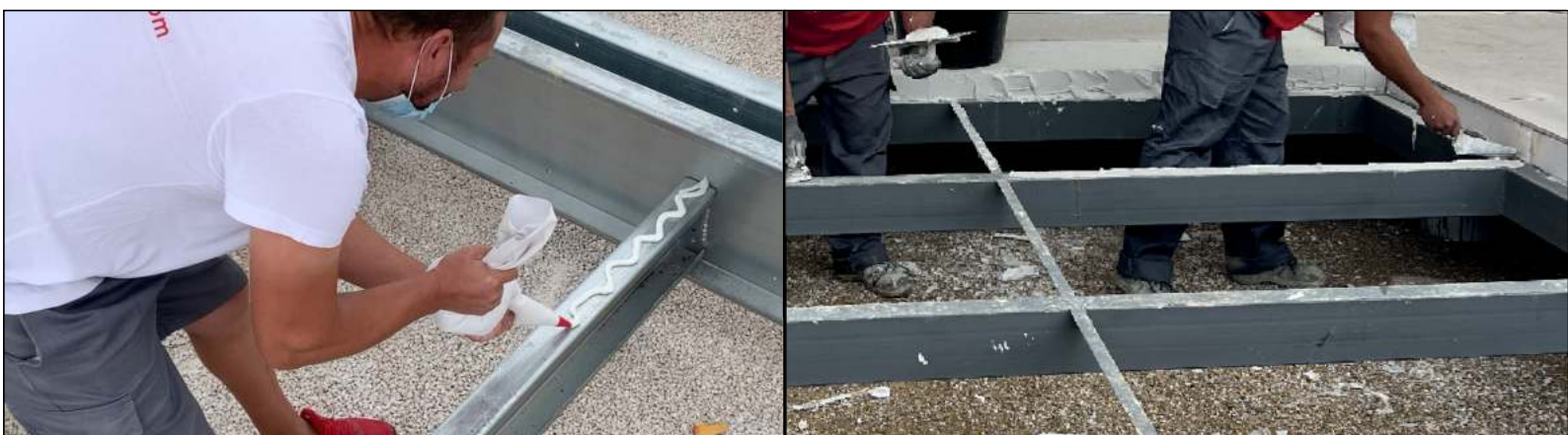
Detalle de colocación de quïckmôrtar
