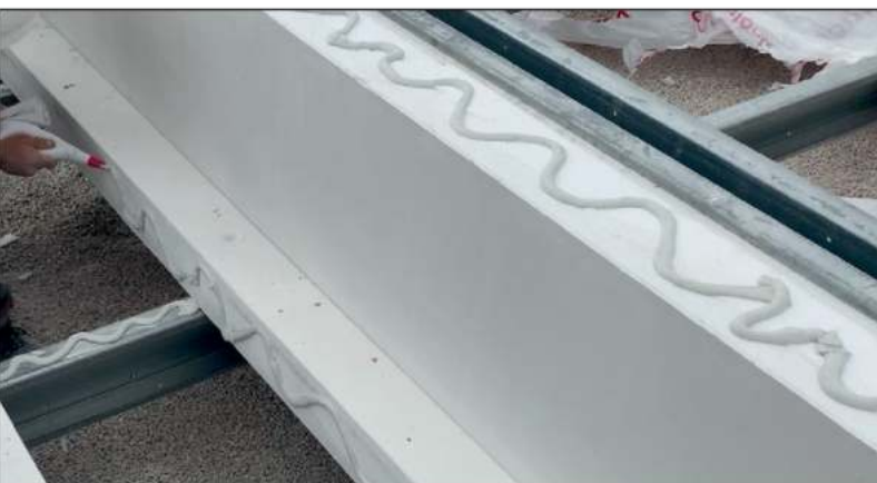
Detalle de mortero intersticial entre paneles
