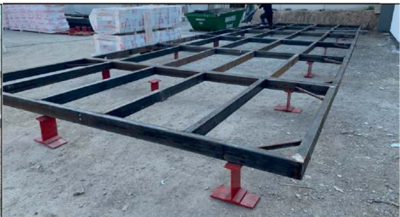
Bastidor inferior metálico Ejemplo unión de módulos pequeños
