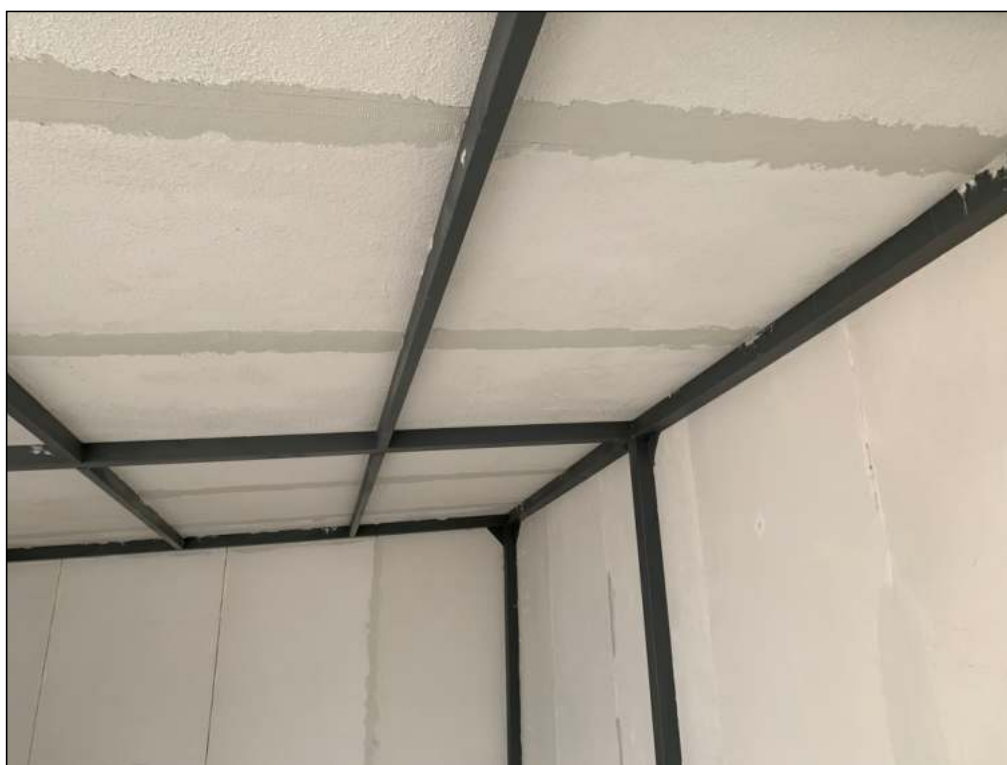
Detalle tratamiento de juntas
