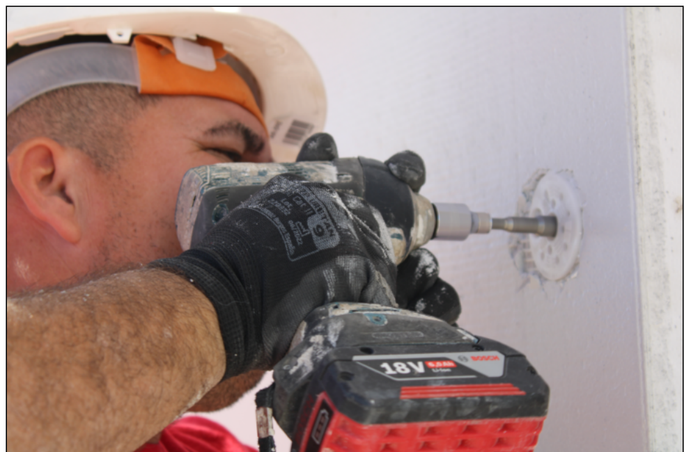
Detalle de atornillado de paneles
