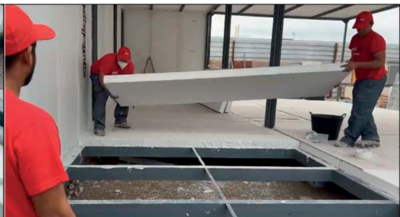
Detalle de colocación de paneles
