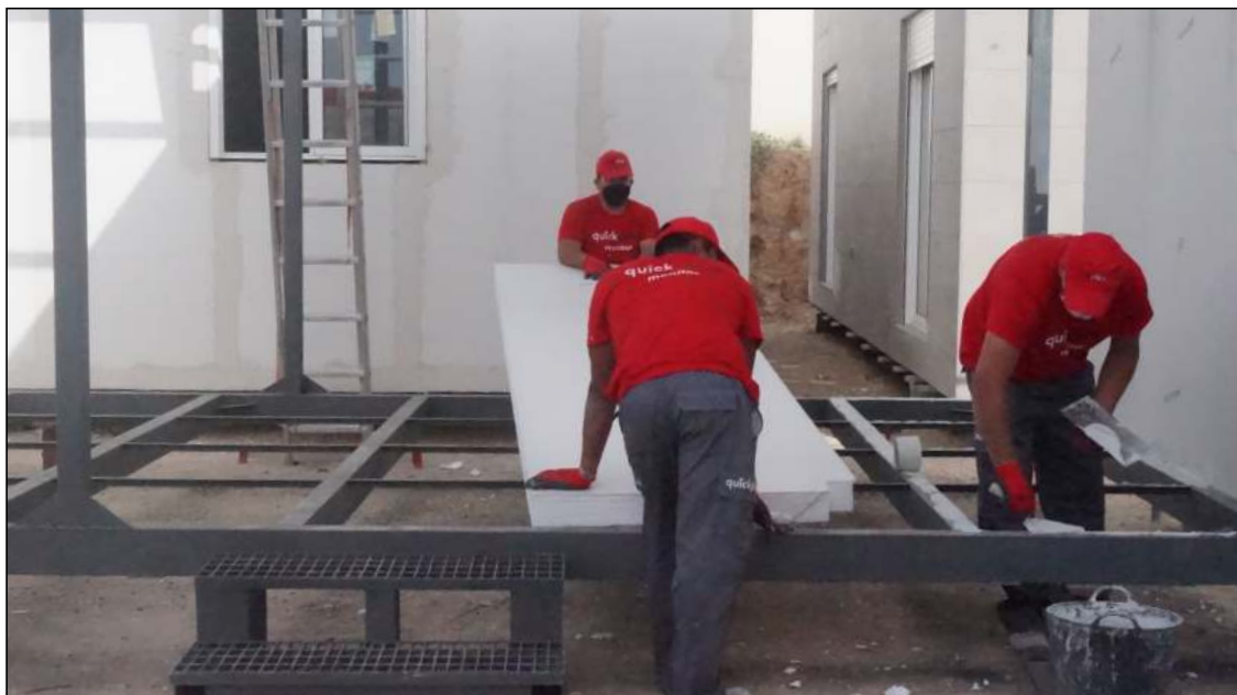
Detalle de colocación de quîckmôrtar y quîckfiber para la colocación de paneles en forjado inferior
