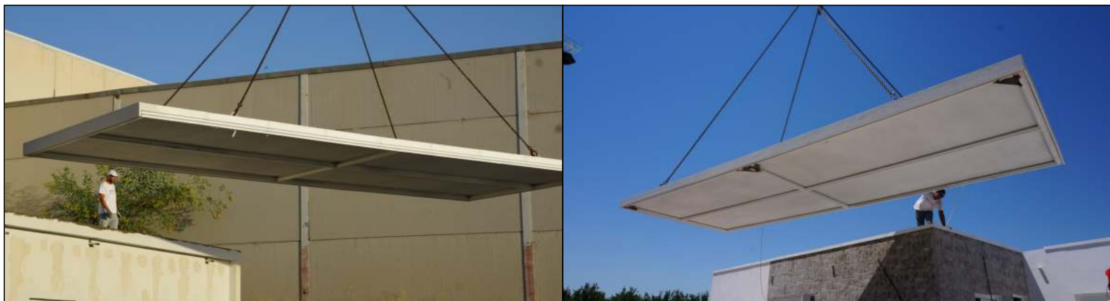
Detalle enganche pérgolas con estructura interna
