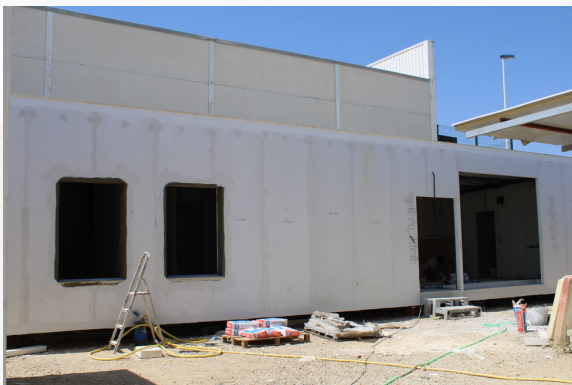
Imgen 7: Impermeabilización de jamba
