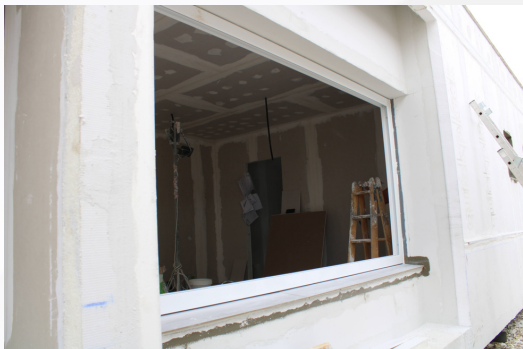
Imgen 11: Trabajos Terminados
