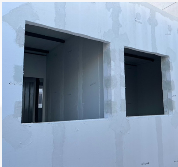
Imgen 5: Tramiento de juntas
