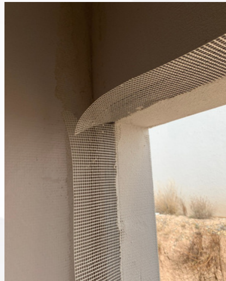
Imgen 2: Colocación de malla perimetral
