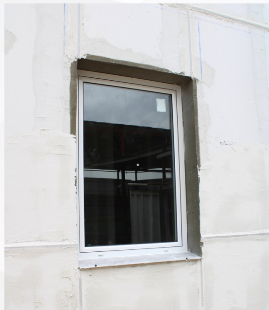
Imgen 4: Atornillado de carpintería
