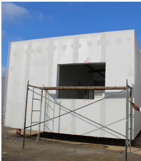
Imgen 1: Colocación de malla perimetral
