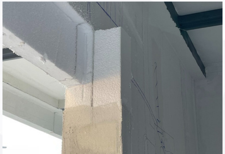
Imagen 6: Obsérvese la preparación para el recibido de la caja de persiana
