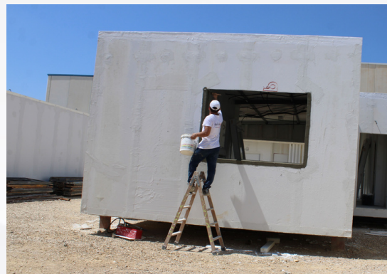
Imgen 8: Impermeabilización de jamba
