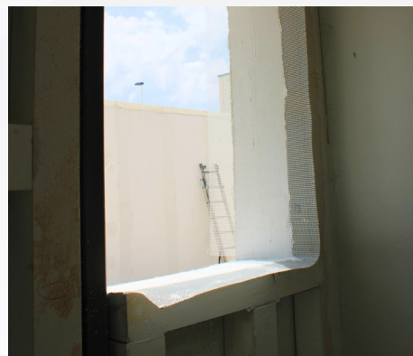
Imgen 4: Colocación de malla perimetral
