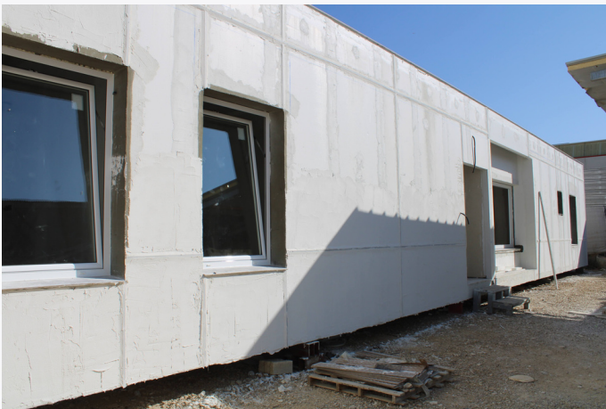
Imgen 9: Trabajos Terminados
