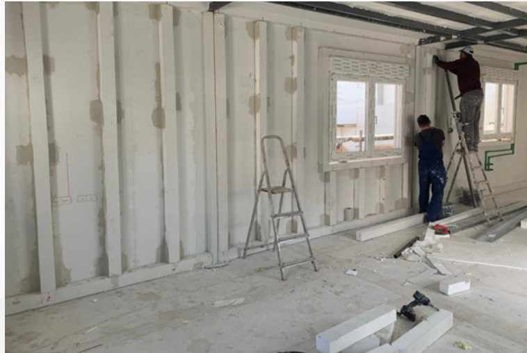
Imgen 1: Montantes de trasdosado
