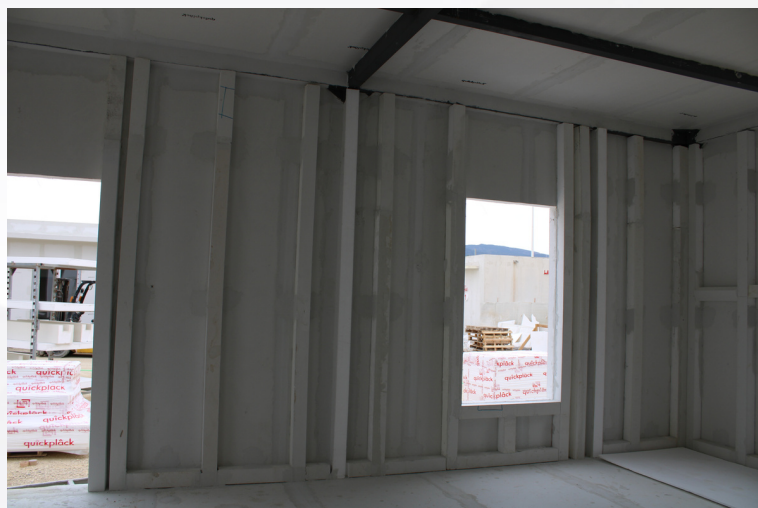
Imgen 2: Montantes de trasdosado
