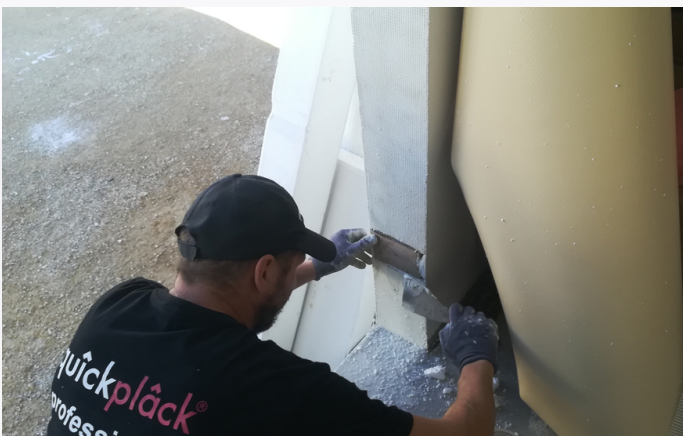
Imgen 2: Instalación de tacos
