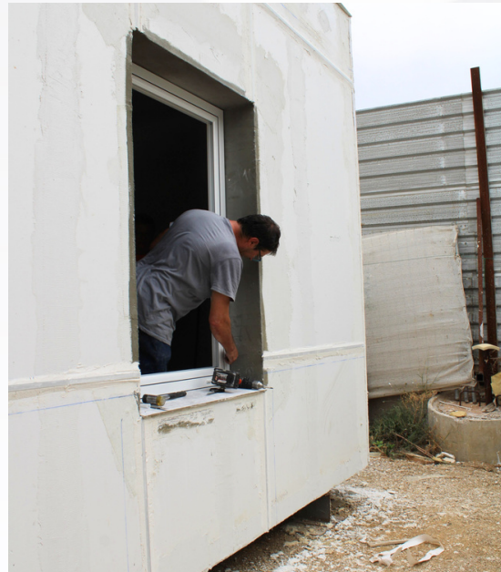
Imgen 2: Atornillado de carpintería
