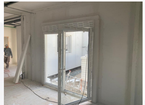
Imgen 13: Trabajos Terminados
