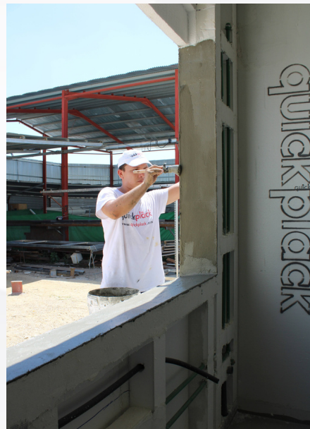
Imgen 6: Impermeabilización de jamba
