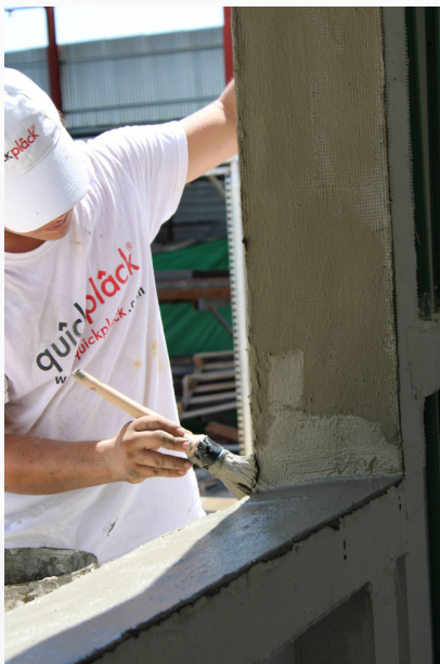
Imgen 5: Impermeabilización de jamba
