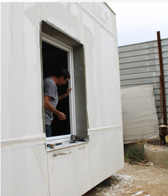
Imgen 3: Atornillado de carpintería
