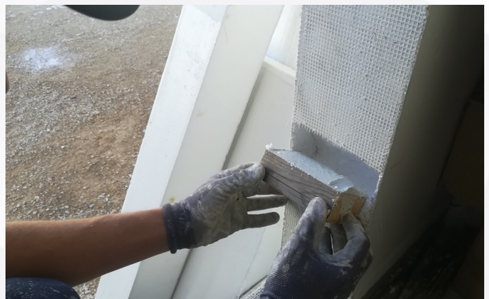
Imgen 3: Instalación de tacos
