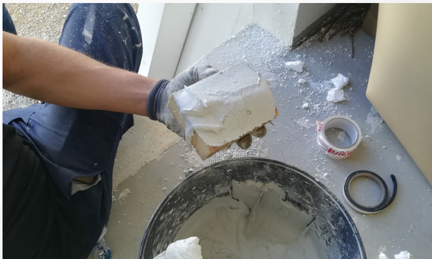
Imgen 1: Instalación de tacos
