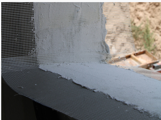
Imgen 3: Colocación de malla perimetral
