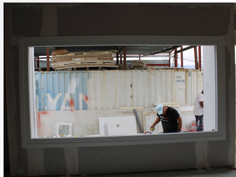
Imgen 12: Trabajos Terminados
