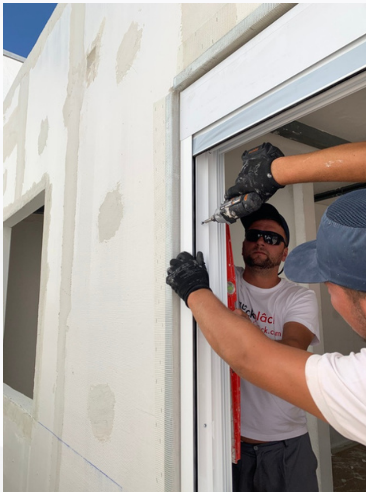
Imagen 1: Instalación de ventana
