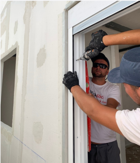
Imgen 1: Atornillado de carpintería
