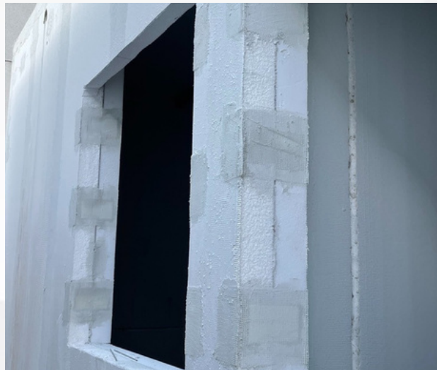
Imgen 4: Tramiento de juntas
