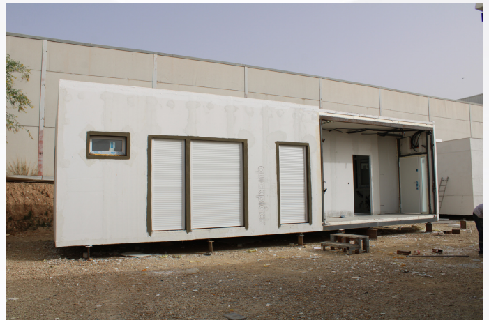
Imgen 10: Trabajos Terminados
