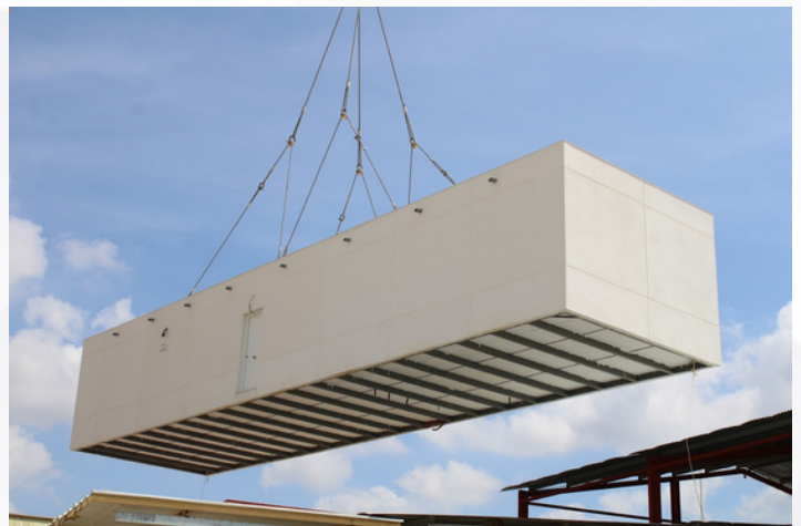
Modulos pre-industrializado de 100m2 durante transporte
